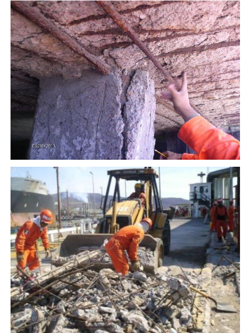
Mantenimiento estructural de muelles.
