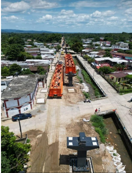
Izaje de estructuras con grúas de hasta 200 toneladas.
