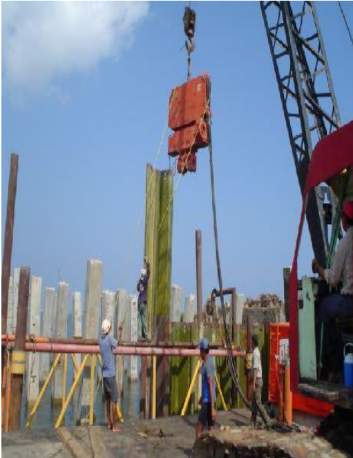
Hincado de Tablaestaca
